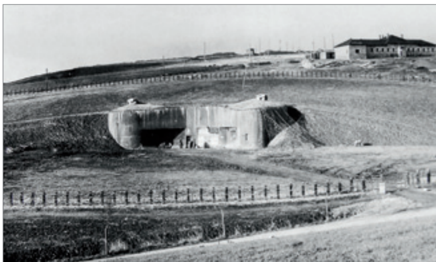
◀ Vchodový objekt S 12a krátce potom, co ho před válkou opustil poslední voják čs. armády (v pozadí budova s kancelářemi stavitele Skorkovského a vojenského stavebního dozoru)
