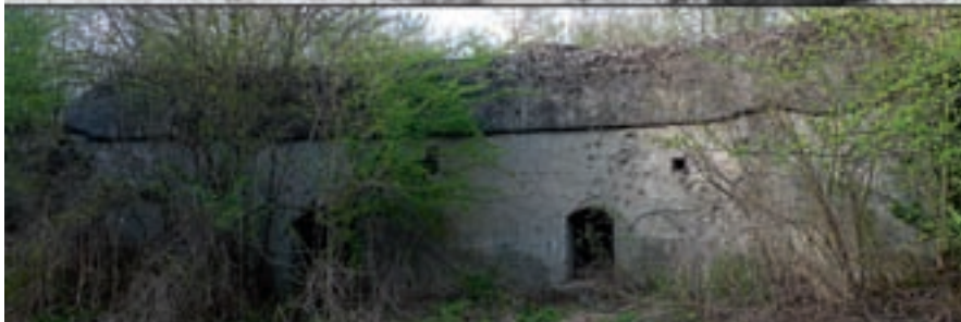
» Méně poškozená pancéřová baterie pro dvě výsuvné věže vz. 02 na pravém křídle fortu v letech 1915 a 2012
